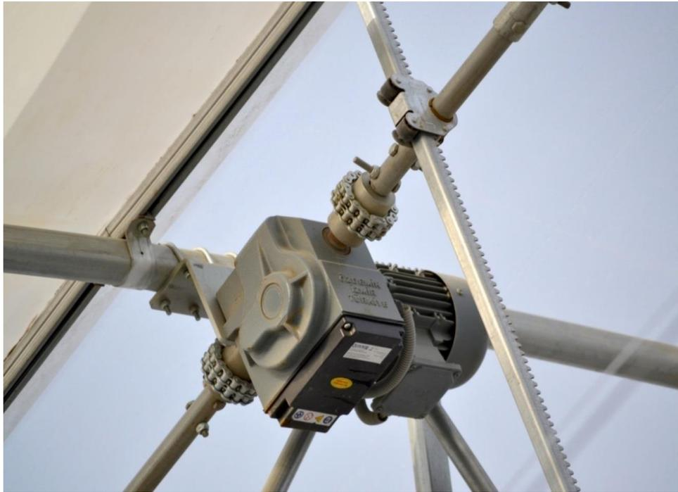
Каждое крыло форточек открывается 1-им мотором, но если теплица превышает 120 метров в длину, используется 2 мотора.
