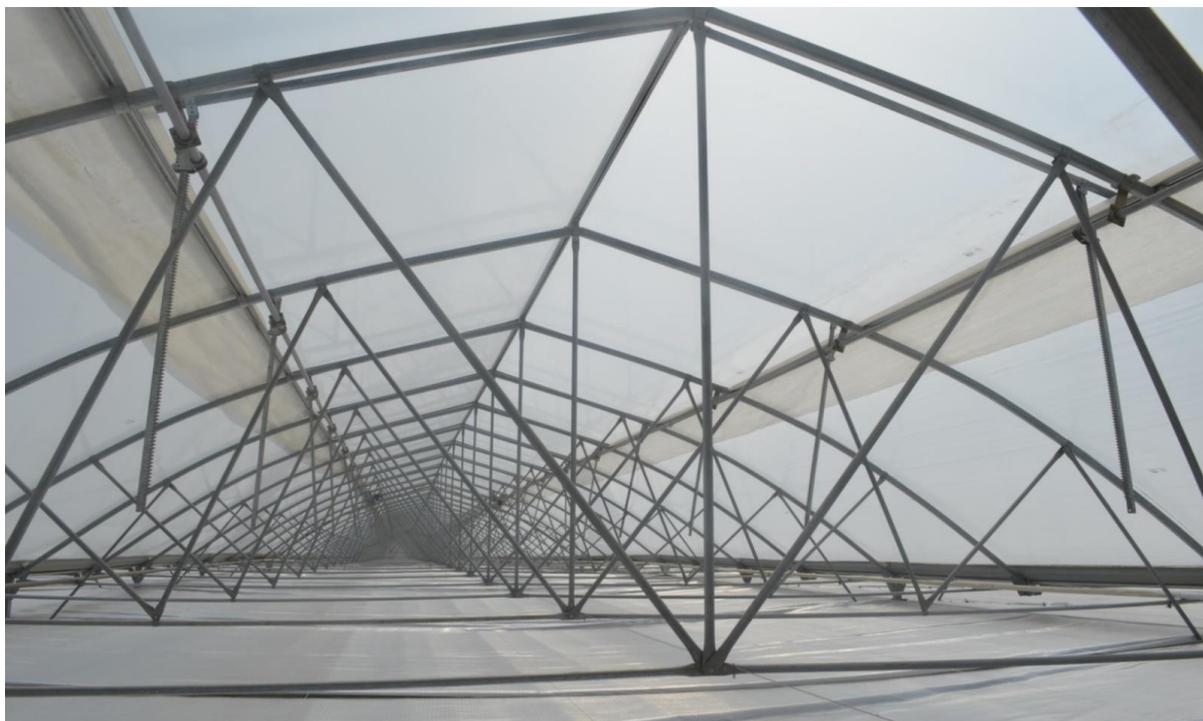
В соответствие с нашими стандартами, фермы монтируются через каждые 2.5 метра. Фермы связываются с 9-ю и 5-ю трубами изнутри. В связи с этим монтируемые нами теплицы выдерживают скорость ветра до 110-120 км/ч и нагрузку до 25 кг/ м<sup>2</sup>.
