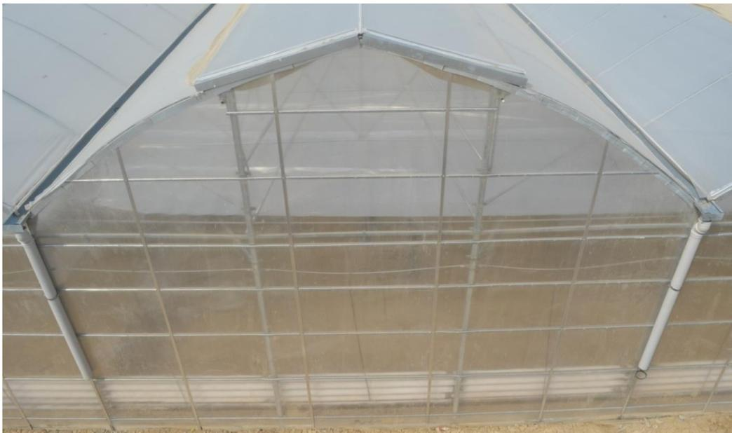
Для обеспечения максимальной защиты от внешних факторов, таких как дождь и ветер, поликарбонатные листы соединяются между собой специальными алюминиевыми профилями.
