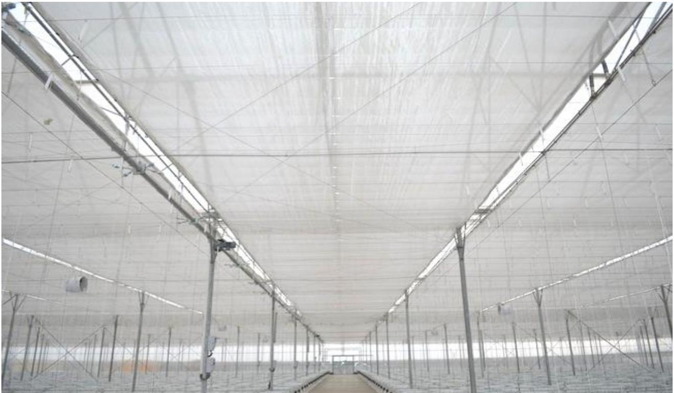
В летний период помещение внутри теплицы сильно прогревается. В этом случае система зашторивания автоматически включается при поступлении сигнала с сенсоров и создается искусственная тень.
