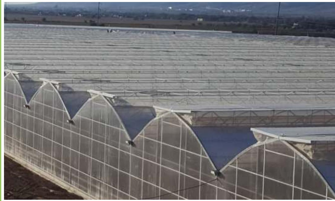
Havalandırma sistemi istixananın üstündə və yanlarında yerləşdirilən tək və yaxud cüt avtomatlaşdırılmış pəncərələr, eləcə də sirkulyasiya pərləri vasitəsi ilə işləyir.
