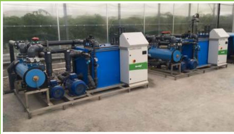
Sulama sistemi tam automatlaşdırılmıştır. Bu sistemə damcı suvarma, drenaj sistemi, avtomatik sulama qurğusu, meteoroloji nəzarət sistemi, gübrə hazırlanması üçün vahid bir sistem daxildir. Müşterinin istəyinə əsasən gübrələrə qənaət (20-25%) etmək üçün, sulama sisteminə drenaj su təmizləmə və yeniden gübrələmə sistemi əlavə olaraq quraşdırılır. Gübrə təmizlənməsi ozon və ultrabənövşəyi şüalanma vasitəsi ilə həyata keçirirlər.
