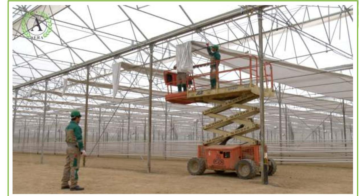
Sera sistemlerimiz Cam, Naylon ve Polikarbon gibi farklı malzemeler ve ebatlarda tasarlanmış olup, her türlü ihtiyaç için çözüm sunabilmektedir. Tesis inşası sırasında kullanılan çelik konstrüksiyon uzun yıllar korozyona karşı dayanıklı olması için standart galvaniz kaplamalı olarak imal edilmektedir, ayrıca istege bağlı olarak boyası ile kaplanabilmektedir. Montaj sürecinde kesinlikle kaynak ile birleştirme kullanılmamaktadır.
