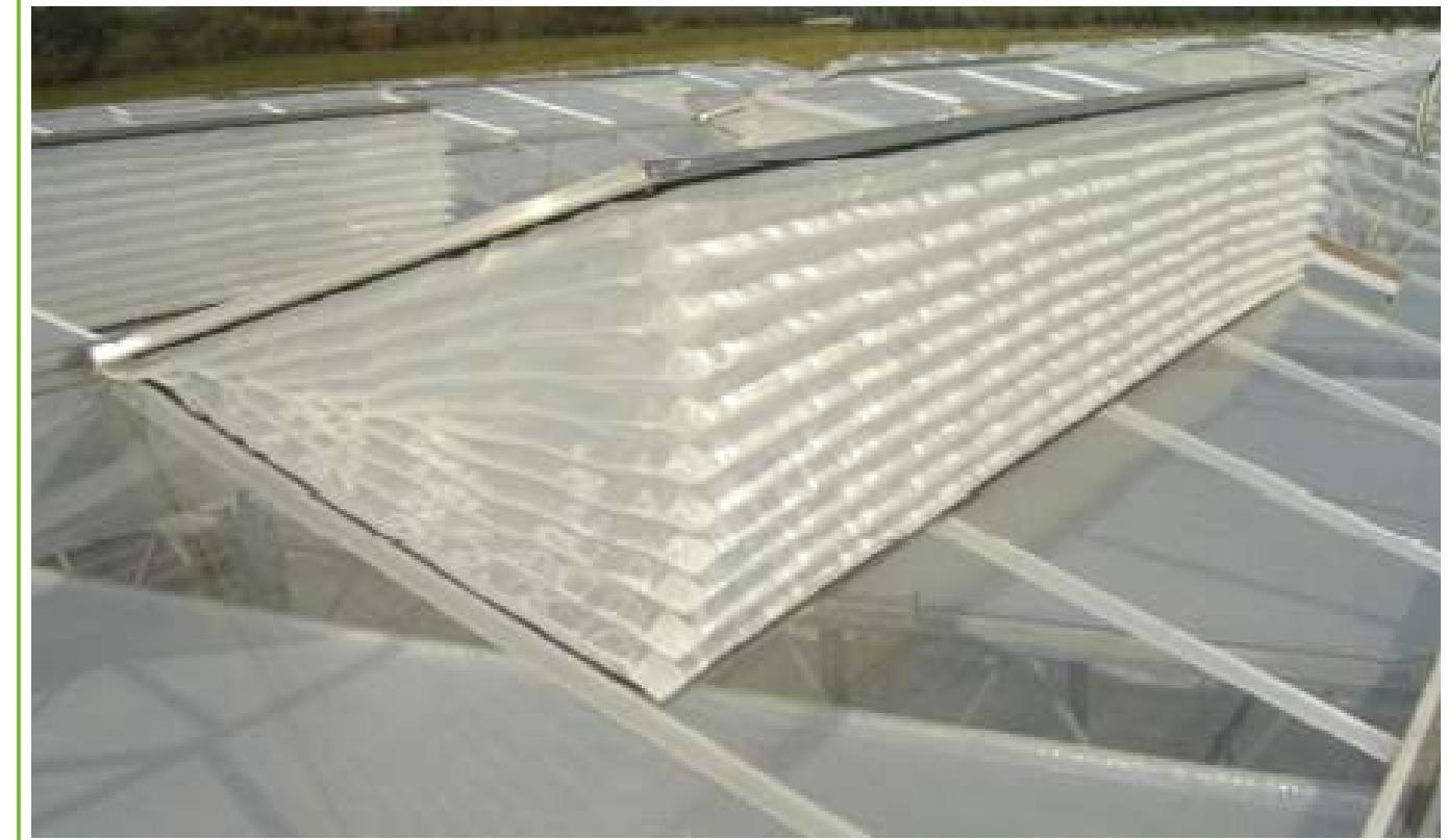
Хаваладırma sistemi seranın üst ve yan kısminında bulunan, otomatik çift ve ya tek pencereler ve fanlar sayesinde çalışmaktadır.
