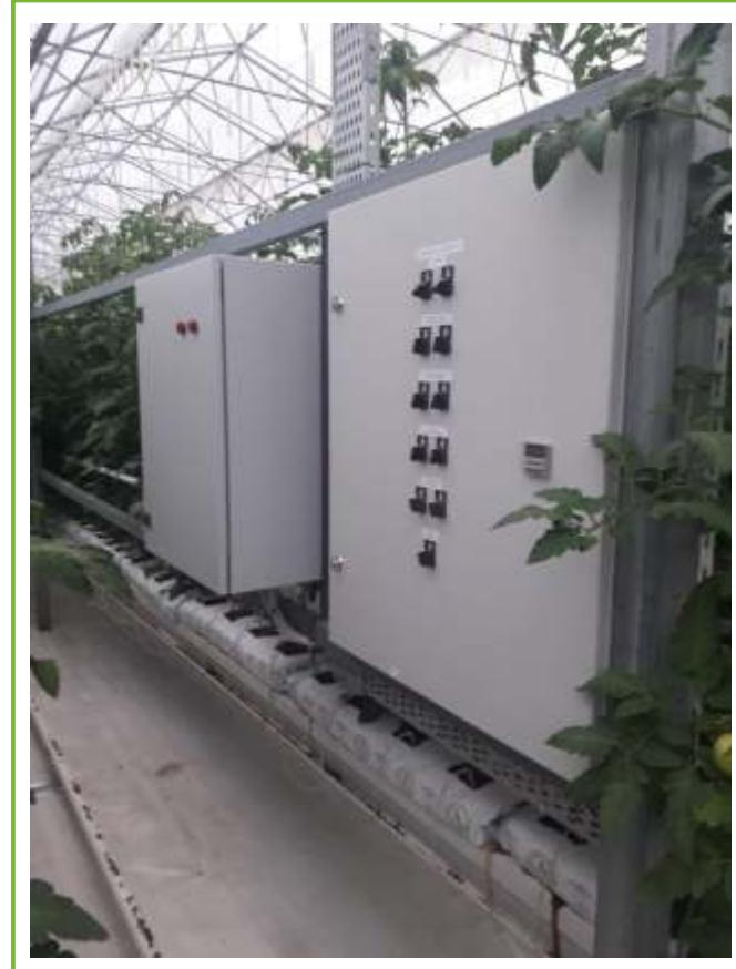
İstixanalarda elektrik sistemi, hər qovşaqda gərginlik düşməsi və enerji fazalarının yerləri dəyişdiyində özünü qorumaya alacaq şəkildə fəaliyyət göstərir. İstifadəsi rahat olması üçün istixana daxilində 220V-380V gücündə elektrik yuvaları quraşdırılır.
