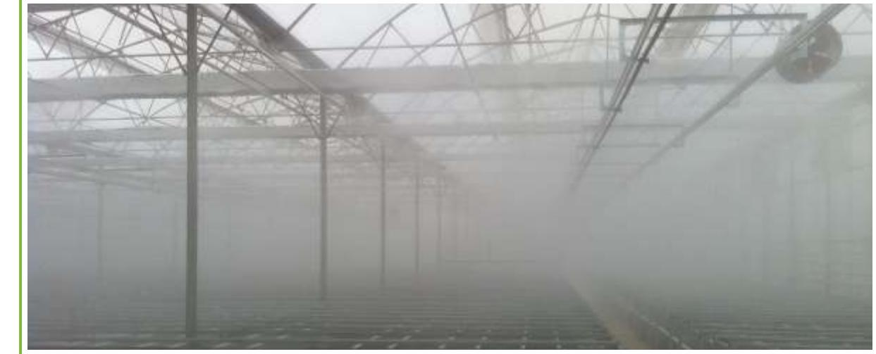
Система затуманивания предназначена для поддержки влажности и температуры в теплице жаркое время года. Система полностью автоматизирована и состоит из нержавеющих стальных труб, а также насосов высокого давления (70-100 амп) производства Италии.
