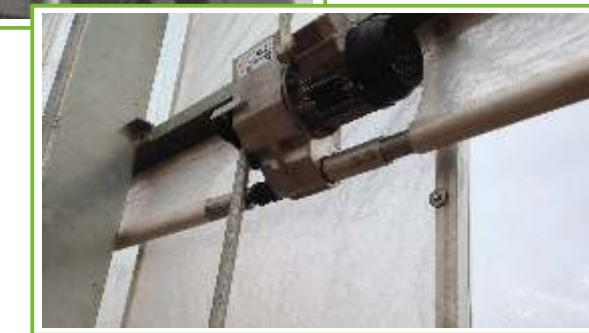
Bu sistem sayesində istixana daxilində iqlimə və enerji itkisinin qarşısının alınmasına nəzarət etmək mümkündür. Quraşdırılan PUSH PULL pərdə mexanizmasında istifadə olunan pərdənin tərkibindəki xüsusi aliminium tellər, isti havalarda zərərli günəş şüalarının istixana daxilinə keçməsinin qarşısını alır, soyuq hava şəraitində isə havanın hərarətinin saxlanmasına köməklik edir.
