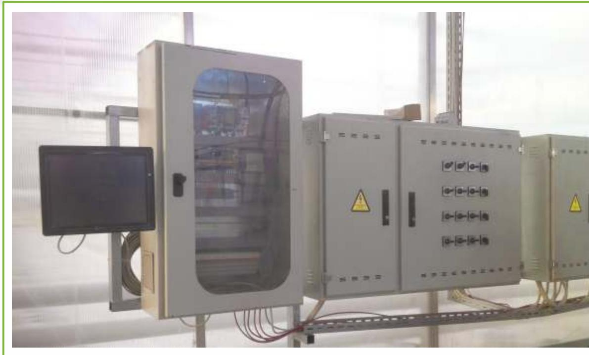
Установка электрической системы осуществляется таким образом, чтобы каждый узел имел свою собственную защиту от перепадов напряжения и от смен места фаз питания. Для удобства в теплицах вдоль дорожек монтируются розетки на 220 и 380 вольт.
